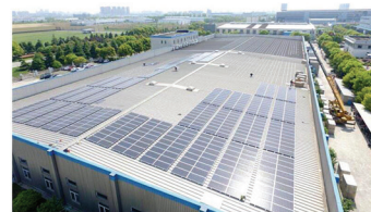
● 屋顶太阳能光伏发电（在建中）
